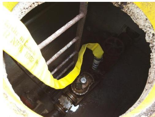
**Photo 49: Meter Test Port**
