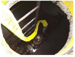
Photo 49: Meter Test Port
